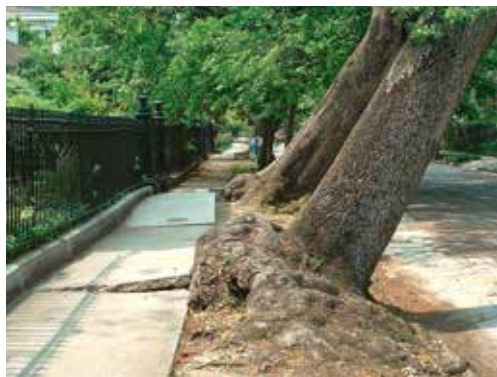
Abbildung 11: Platanen am Straßenrand: Stützwurzeln konnten Richtung Fahrbahn nicht entwickelt werden. Zugwurzeln haben sich unter dem Gehweg in den benachbarten Garten entwickelt (Foto: DR. CLEMENS HEIDGER, Hannover)
