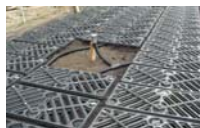
Kabelrør eller plads øverst i SilvaCell
