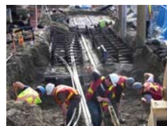
Kabelrør eller plads øverst i SilvaCell
