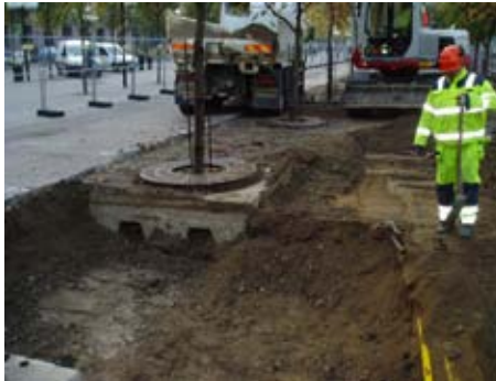
Utläggning av skelettjord sker efter utförd schakt. Observera den utlagda växtjorden som skyddar befintligt rotsystem vid respektive betonglåda. Det är väsentligt att man gräver in i betonglådans öppningar så att man blottlägger befintligt rotsystem. (Foton: Björn Embrén)
