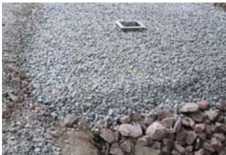
Luftigt bärlager utlagt kring luftbrunn. Geotextil läggs ut innan samkross och beläggning påförs. (Foton: Björn Embrén)
