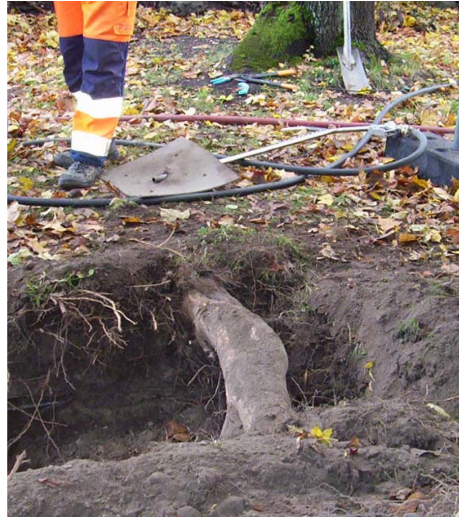
Träd kan i trånga situationer utveckla grova rötter, s.k. pipelines, vilka försörjer trädividen med en stor del av dess upptag av näring och vatten. Dessa rötter är viktiga att spara vid växtbäddsdreneringar. Med vakuumteknik kan man schakta fram och kartlägga var dessa rötter går utan att skada rotsystemet. Vid traditionell maskinschakt finns en uppenbar risk att skada dessa grova rötter. (Foton: Örjan Stål)
