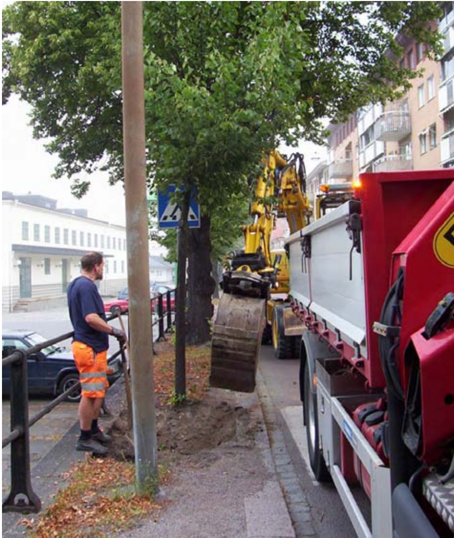
Befintliga lindar med vägöverbyggnad på det gamla rotsystemet. En minimal mittremsa med stenmjöl och kantsten har anlagts i trädradens linje med en bredd som motsvarar diametern på befintliga trädstammar.
