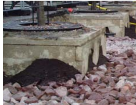
Utläggning av skelettjord sker efter utförd schakt. Observera den utlagda växtjorden som skyddar befintligt rotsystem vid respektive betonglåda. Det är väsentligt att man gräver in i betonglådans öppningar så att man blottlägger befintligt rotsystem. (Foton: Björn Embrén)
