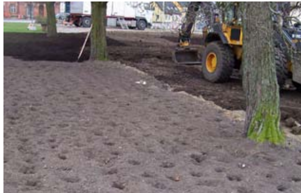
Tryckluftslans används dels för att skjuta loss jord vid rotvänlig schakt och dels för att luckra den gamla parkytan. Framschaktat rotsystem skyddas med utlagd växtjord.
