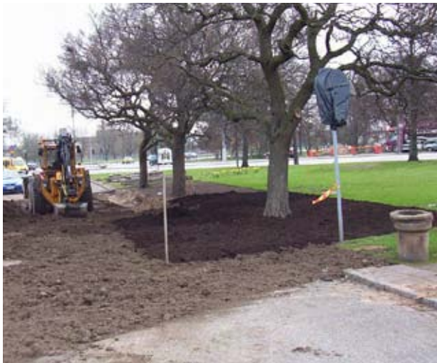
Utläggning av ny växtjord typ A i schaktgropen för gamla vägen. Ett nytt extra näringsrikt lager av mullrik växtjord läggs ut på det luckrade framschaktade rotsystemet. Slutligen färdigställande av ny sammanbunden parkyta med växtbäddsdrenoverade ytor.
