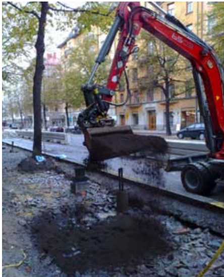
Utläggning av skelettjord för träd i hårdgjord yta. Bilderna visar skelettstruktur med luftigt bärlager, luftbrunn typ TLV 2333 Clarova med betäckning, utläggning av växtjord typ D samt utlagt luftigt bärlager vid luftbrunn. (Foto: Örjan Stål)
