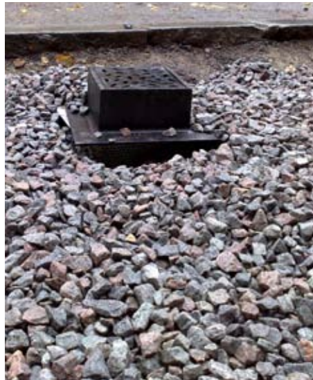
Utläggning av skelettjord för träd i hårdgjord yta. Bilderna visar skelettstruktur med luftigt bärlager, luftbrunn typ TLV 2333 Clarova med betäckning, utläggning av växtjord typ D samt utlagt luftigt bärlager vid luftbrunn. (Foto: Örjan Stål)
