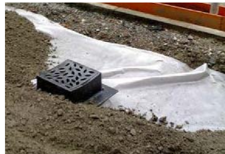
Luftigt bärlager utlagt kring luftbrunn. Geotextil läggs ut innan samkross och beläggning påförs. (Foton: Björn Embrén)
