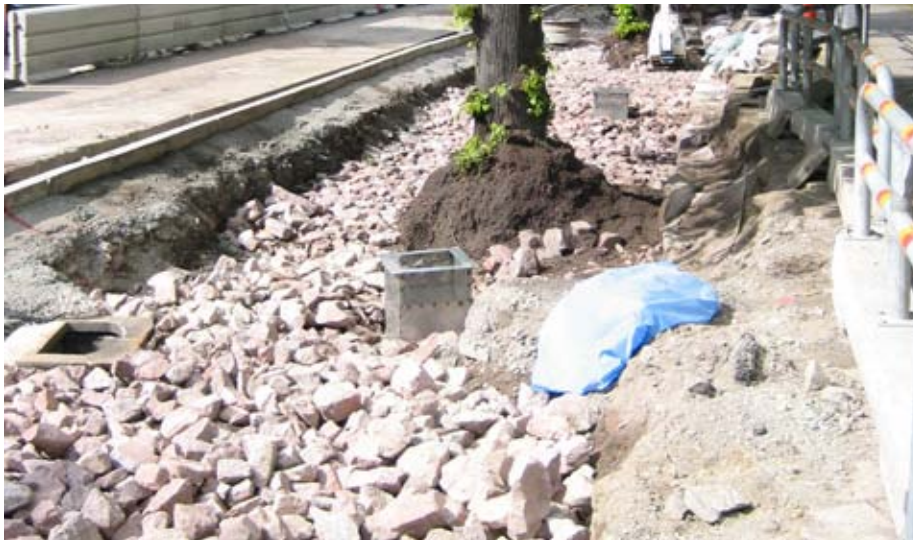
Befintliga gatuträd efter utfört schaktarbete. Utläggning av skelettskärv har påbörjats och luft- och dagvattenbrunnar har placerats ut direkt på skärven. (Foto: Björn Embrén)
