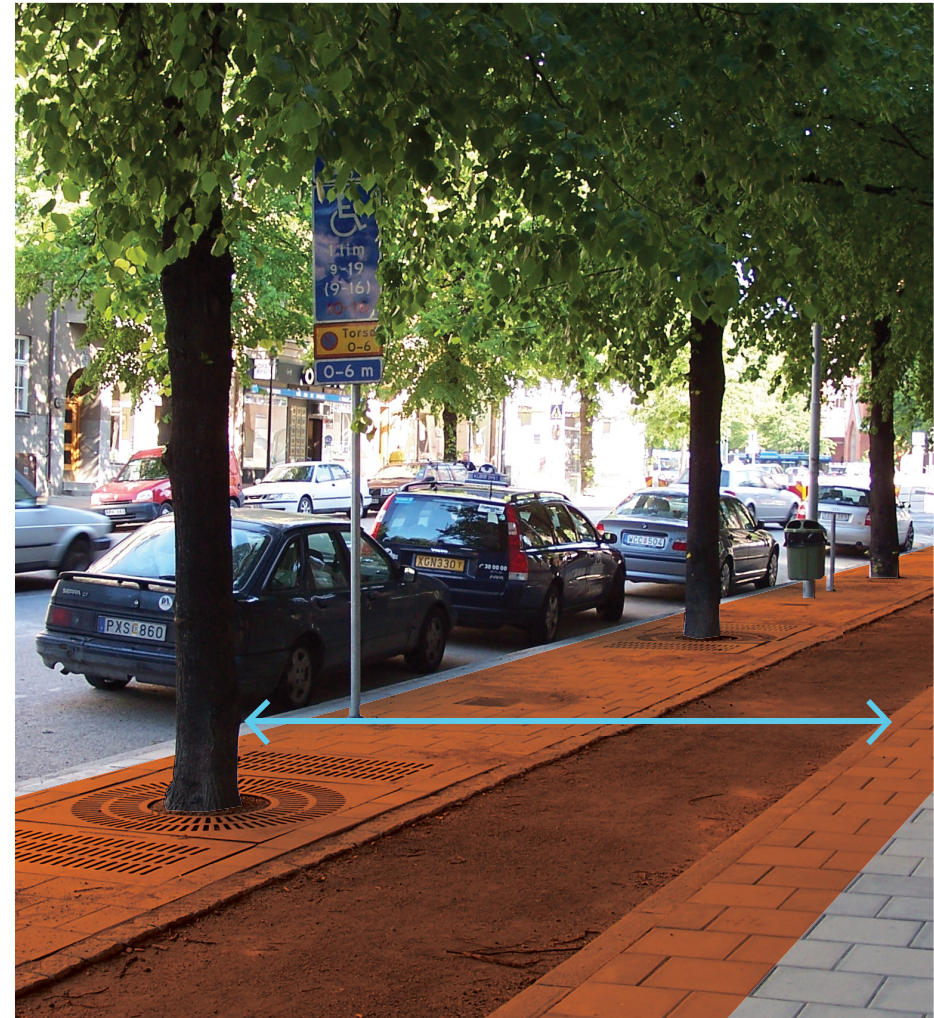
Wiederherstellung einer neuen Oberflächenschicht mit Betonplatten. Rahmen für Baumgitter wird auf Betonkasten oder Betonschwellen ausgelegt. Die fertige Anlage hat ein wurzelbares Pflanzvolumen von 15 m 3 für jeden Baum. Das orangefarbene Feld illustriert in etwa die Breite der zusammenhängenden Fläche der Skeletterde (Fotos: Björn Embrém)
