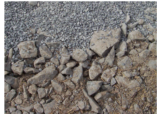
Ein luftiges Volumen mit tragenden Eigenschaften für einen Parkplatz. Verschiedene schliessende Schichten aus Schotter werden aufeinander gelegt. Die Fraktion der Schotterebenen nimmt allmählich ab, je höher im Profil sie ausgelegt werden. (Fotos: Örjan Stål)
