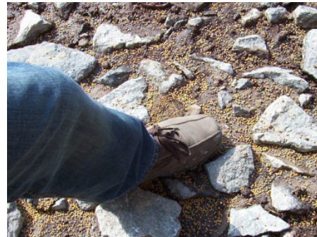
Pflanzerde Typ D wird in die Skelettschicht untergewässert. Düngemittel wird direkt auf das Skelettvolumen verteilt. (Foto: Örjan Stål)
