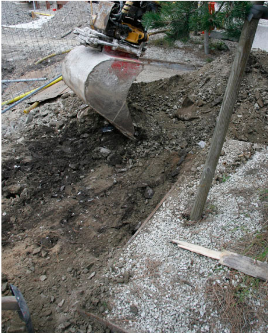
Maschinenschacht und Handschacht in der Nähe einer Baumgrube in vorhandener Skeletterde. (Foto: Örjan Stål)
