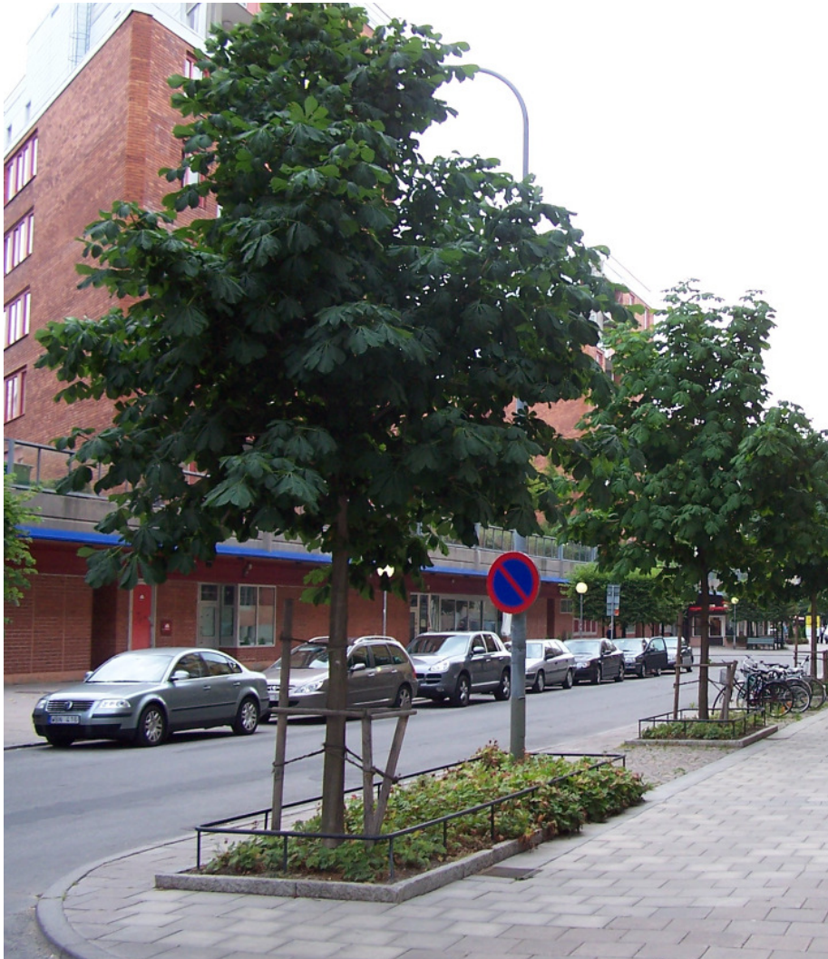
Neuangelegter Gehsteig mit Straßenbäumen in Stockholm. Die Bäume haben eine Unterbepflanzung mit Geranium. Es wurden 15 m 3 verdichtungsbaren Boden/Baum und eine luftige Tragschicht unter die versiegelte Fläche gelegt. Niederschlagswasser von den Hausdächern wird über schalenförmige Betonrinnen an Lüftungs- und Niederschlagswasserbrunnen geleitet. (Foto: Björn Embrém)
