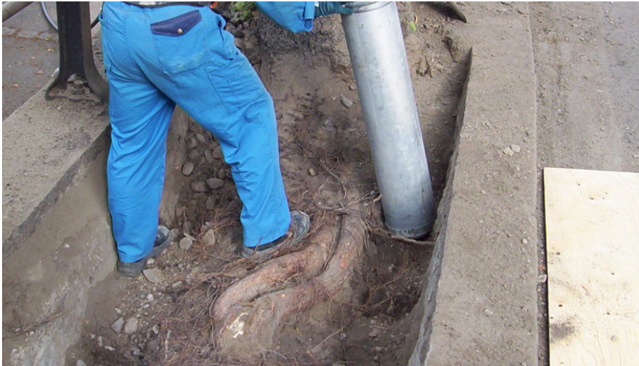
In Baumnähe und wenn grosse Baumwurzeln vorhanden sind, wird wurzelfreundlich ausgeschachtet. (Foto: Örjan Stål)
