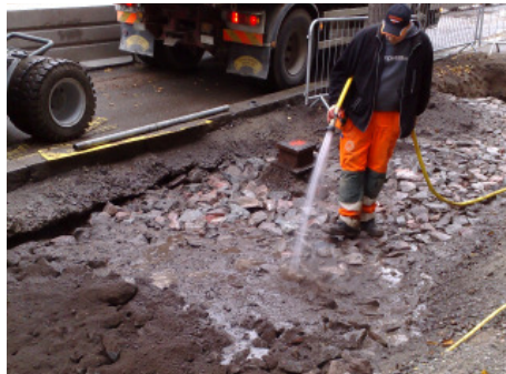
Pflanzerde Typ D wird in die Skelettschicht untergewässert. Düngemittel wird direkt auf das Skelettvolumen verteilt. (Foto: Örjan Stål)
