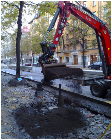
Die Auslegung von verdichtungsbarem Boden für Bäume in versiegelter Fläche. Die Abbildungen zeigen die verdichtungsable Bodenstruktur mit luftigem Tragschicht, Luftbrunnen vom Typ TLV 2333 Clarova mit Überdeckung, Auslegung von Pflanzeerde Typ D sowie ausgelegte, luftige Tragschicht am Luftbrunnen. (Foto: Örjan Stål)
