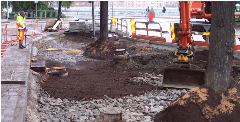
Unterspülung von Pflanzerde Typ D im verdichtungsbaaren Schotter. (Foto: Björn Embrém)
