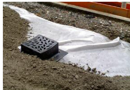
Eine luftige Tragschicht wurde rings um einen Luftbrunnen ausgelegt. Danach kommt Geotextil und zum Schluss Splittermaterial und Belag. (Foto: Björn Embrém)
