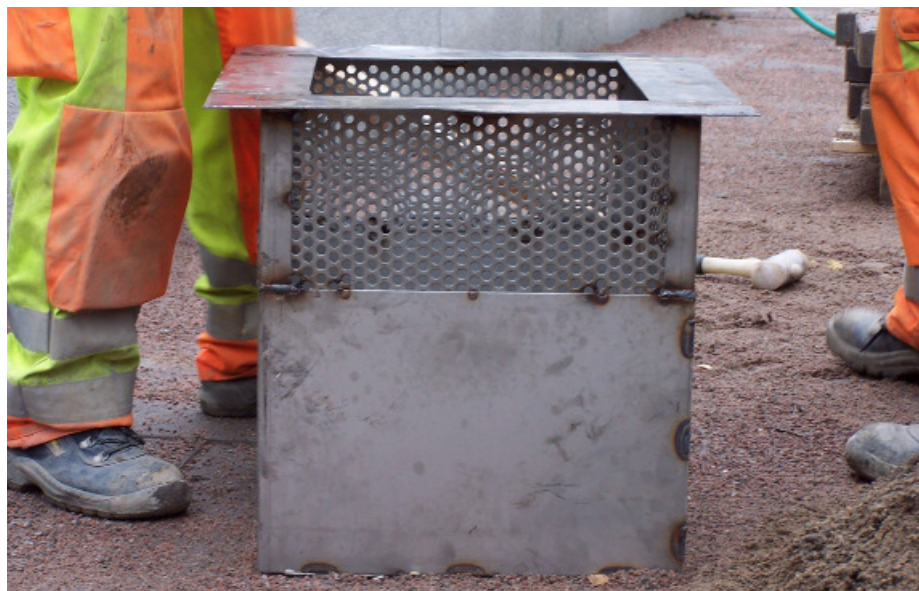
Luftbrunnen vom Typ TVL 2333 Clarova. Der Brunnen wird direkt auf den verdichteten Boden gesetzt. Der Brunnen transportiert Niederschlagswasser in den verdichteten Boden und sorgt gleichzeitig für Luftzufuhr, was den für Bäume lebenswichtigen Gasaustausch in den Bodenschichten ermöglicht. Es gibt auch Brunnen, bei denen die ganzen Seiten perforiert sind. (Foto: Björn Embrém)
