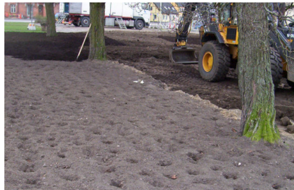
Eine Druckluftlanze wird benutzt, teils zum Losschiessen der Erde bei wurzelfreundlicher Ausschachtung, teils zum Auflockern der alten Parkfläche. Ausgeschachtetes Wurzelsystem wird mit ausgelegter Pflanzerde geschützt.
