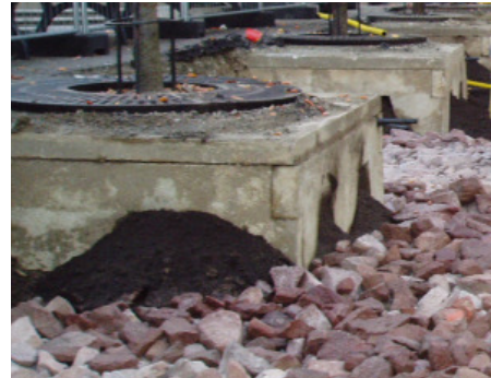
Nach der Ausschachtung wird die Skeletterde ausgelegt. Bitte die ausgelegte Pflanzerde beachten, die das vorhandene Wurzelsystem am jeweiligen Betonkasten schützt. Es ist wichtig, die Öffnungen des Betonkastens einzugraben, sodass das Wurzelsystem freigelegt wird. (Foto: Björn Embrém)
