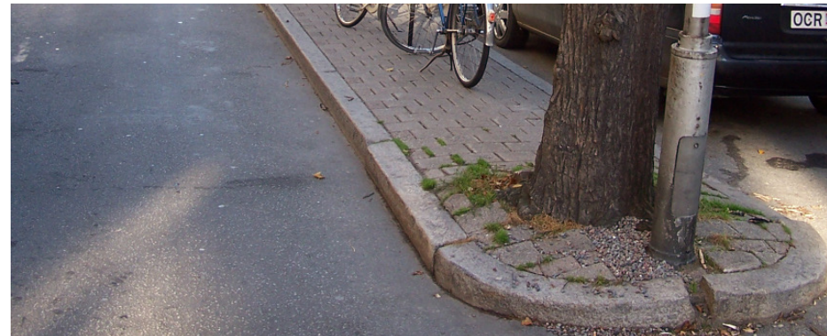
Vorhandene Linden in Norrullsgatan in Stockholm. Die Begegnung der Baumstämme mit dem Belag zeugt von einer Auffüllung des Bodens um die Bäume herum. Die Baumwurzeln haben auch Belag und Kantsteine angehoben. (Foto: Björn Embrém)
