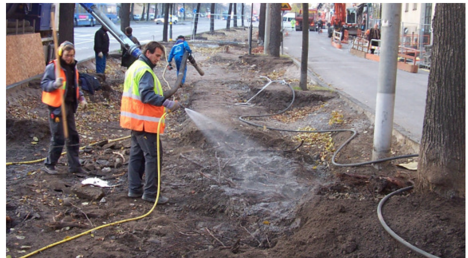
Durch Bewässerung und Auslegung von neuer Pflanzerde wird das vorhandene ausgeschachtete Wurzelsystem gegen Austrocknung geschützt. (Foto: Björn Embrém)
