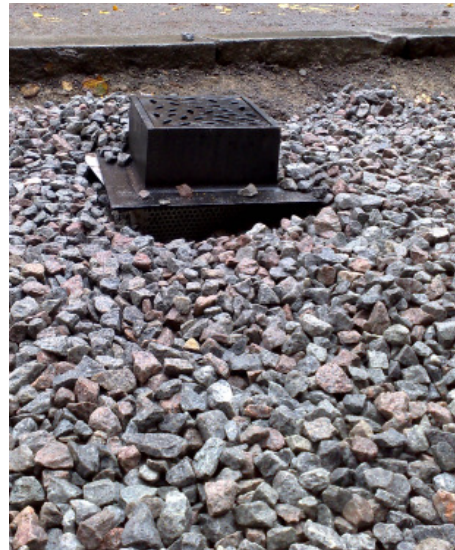
Die Auslegung von verdichtungsbarem Boden für Bäume in versiegelter Fläche. Die Abbildungen zeigen die verdichtungsable Bodenstruktur mit luftigem Tragschicht, Luftbrunnen vom Typ TLV 2333 Clarova mit Überdeckung, Auslegung von Pflanzeerde Typ D sowie ausgelegte, luftige Tragschicht am Luftbrunnen. (Foto: Örjan Stål)
