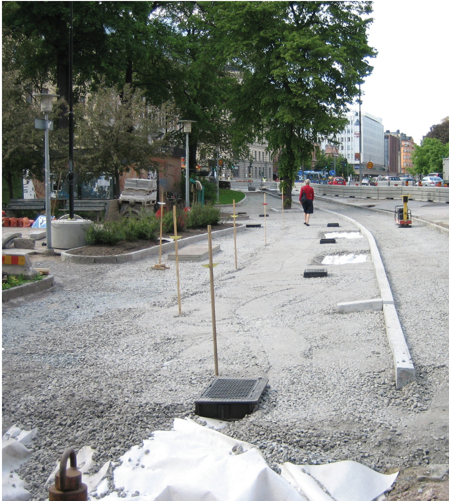
Luft- und Abwasserbrunnen Typ Clarova, hier mit Abdeckungen aus vergütetem Eisen, und komprimierte Tragschicht. Die Strecke enthält sowohl neue Pflanzgruben als auch Pflanzgrubenrenovierungen für vorhandene Strassenbäume.
