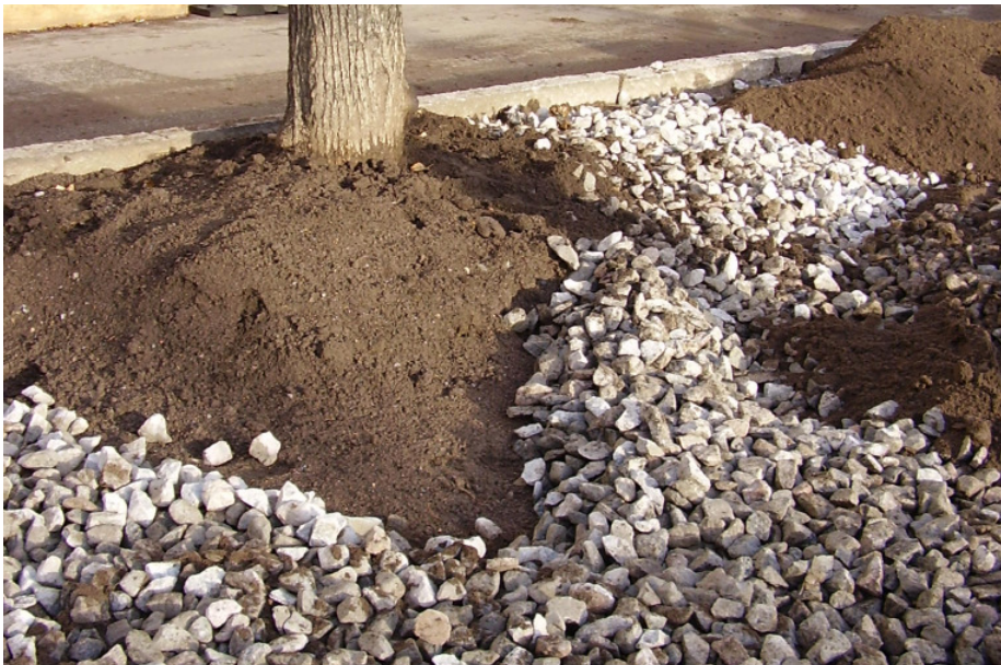
Eine luftige Schicht Schotter 32-63 mm wird auf eine aufgelockerte Terrasse ausgelegt. Die Schotterschicht wird nicht komprimiert. Der Schotter soll die Luftigkeit im neuen Erdprofil sicherstellen. Auf die luftige Schotterschicht wird die nährstoffreiche Pflanz Erde ausgelegt und untergewässert. (Örjan Stål)
