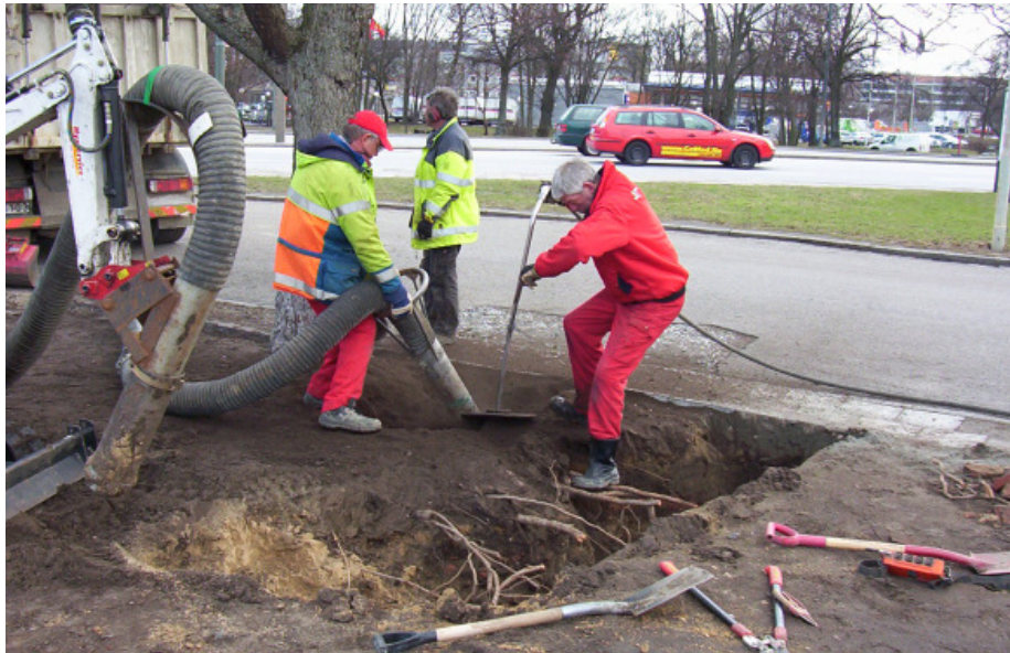
An empfindlichen Standorten mit vielen Baumwurzeln wird wurzelfreundlich ausgeschachtet. Hier mit einem Vakuumsauggerät sowie Druckluftlanze. Die Metalllanze wird sowohl für Ausschachtung als auch Auflockerung benutzt.
