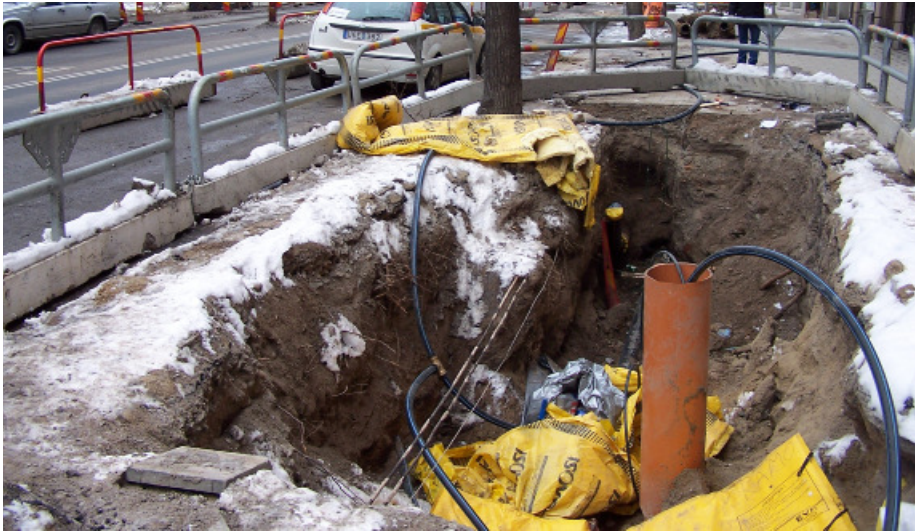
Ein neu ausgeschachteter Gehweg dicht an einer Parklinde in Birger Jarlsgatan in Stockholm. Eine gewöhnliche Bodensituation für Stadtbäume, wo Leitungsschächte und versiegelte Flächen in der unmittelbaren Baumnähe angelegt werden. Der Baum hat ein minimales und kompaktes Wurzelsystem entwickelt. Wiederholte Ausschachtungen und schlechte Wachstumsvoraussetzungen ergeben kleine Entwicklungsmöglichkeiten im Boden. (Foto: Björn Embrém)
