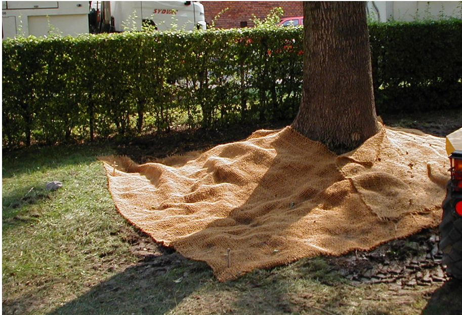
Schutz für freigelegte Wurzeln aus Kokosnuss/Jute. (Foto: Örjan Stål)
