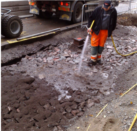
(Foto: Örjan Stål)
