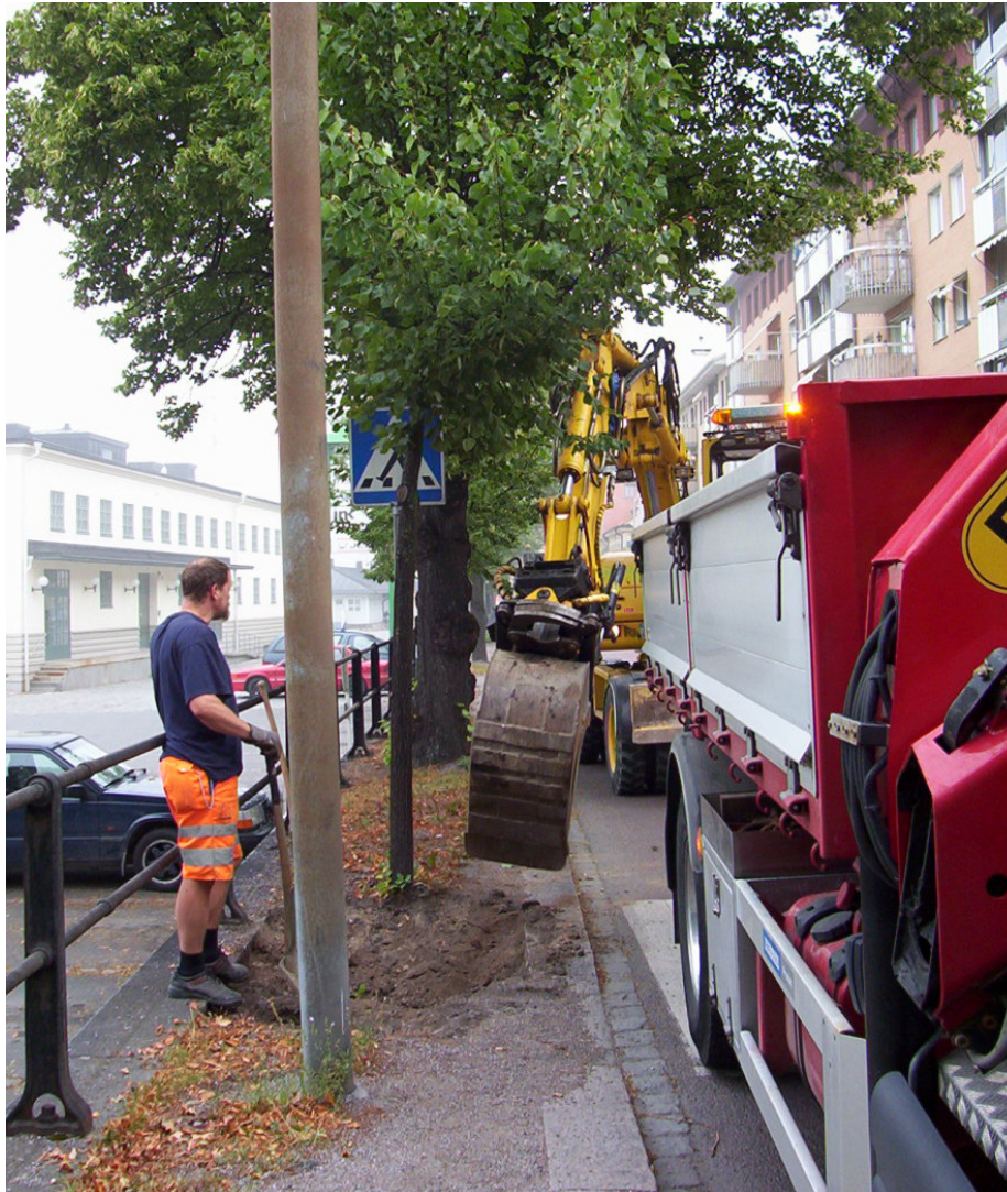
Vorhandene Linden mit Strassenaufbau über dem alten Wurzelsystem. Ein minimaler Mittelstreifen mit Steinmehl und Kantsteinen wurde an der Baumlinie entlang angelegt mit einer Breite, die dem Diameter der vorhandenen Baumstämme in etwa entspricht.
