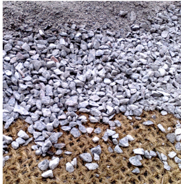
Kokosnetz als Materialtrennschicht bei einem Kiesbelag.
