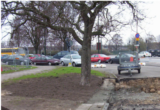
Vorhandene Weissdornbäume in Malmö neben einer alten Strasse. Die Strasse soll entfernt und eine zusammenhängende Parkfläche angelegt werden. Beim Probeschachten werden keine Baumwurzeln im Strassenaufbau angetroffen. Deshalb kann der restliche Strassenaufbau mit der Maschine ausgeschachtet werden..
