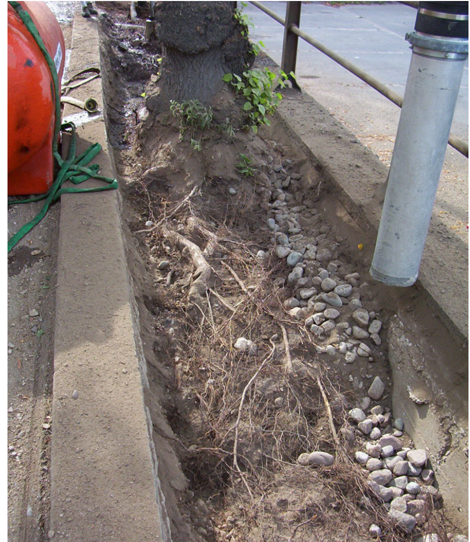
Hier wird wurzelfreundliche Ausschachtung ausgeführt, um das Aufbaumaterial schonend zu entfernen und das vorhandene Wurzelsystem freizulegen. Ein dichter Teppich des feinen Wurzelsystems wird hervorgeholt vor der Wiederherstellung der Pflanzgrube mit luftiger Tragschicht. (Fotos: Örjan Stål)
