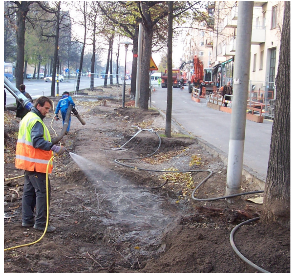
Bewässerung freigelegter Wurzeln bei Vakuumschachtarbeiten als Schutz gegen Austrocknen. (Fotos: Björn Embrém)
