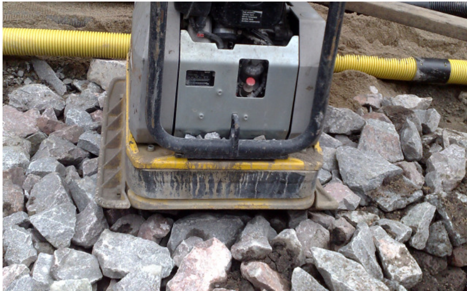
Maschine zum Kompaktieren der Skelettschicht. Die Bilder auf der folgenden Seite illustrieren Teile des Arbeitsgangs für die Anlage von Skeletterde. (Foto: Örjan Stål)
