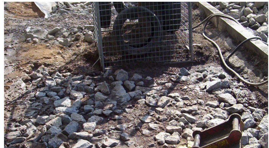
Skelettvolumen mit der richtigen Menge untergespülter Erde. (Foto: Björn Embrém)
