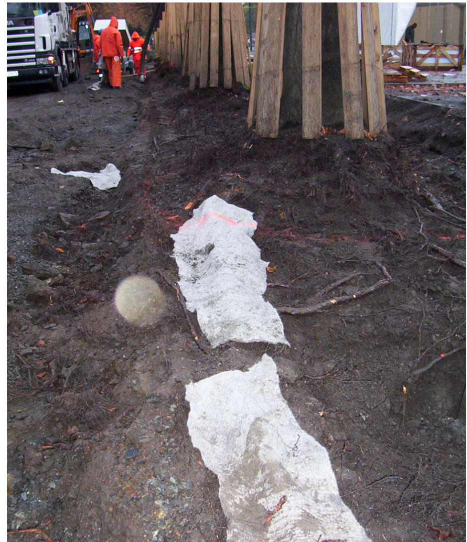
Geotextil wurde auf grobe Baumwurzeln als Schutz gegen scharfe Steine vor der Wiederauffüllung ausgelegt. (Fotos: Örjan Stål)
