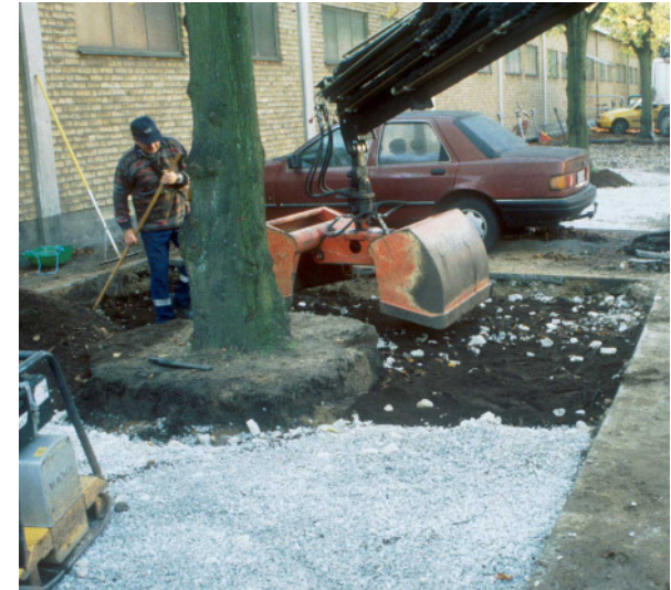
Fertigstellung einer Parkplatzfläche mit durchlässiger Oberflächenschicht aus Schotter.
