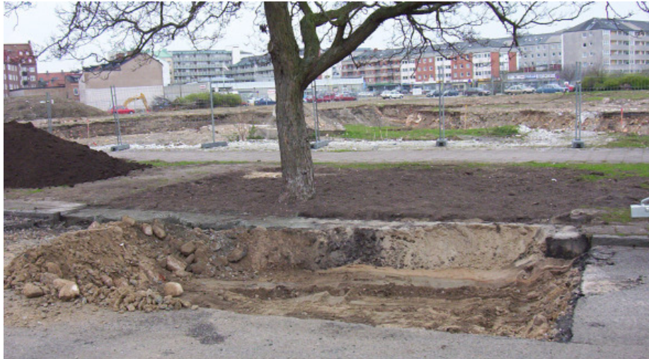
Probeschacht in einer Straße in Baumnähe. Keine Baumwurzeln wurden hier im Fahrbahnaufbau angetroffen..
