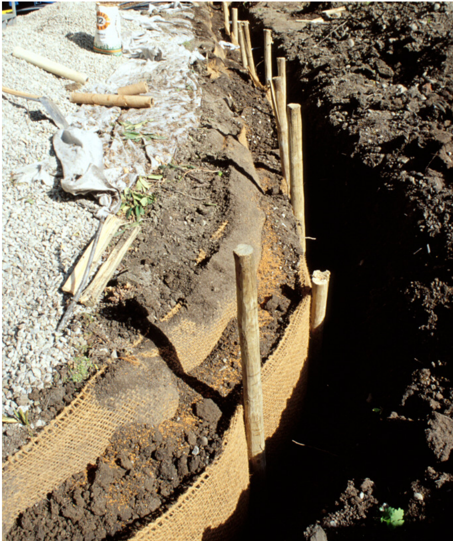
Ein Wurzelvorhang wird hier aus einer Kokosmatte gebaut, abgestützt gegen Holzpfähle und mit feuchter Erde. Wenn die Grube nicht sofort wiederaufgefüllt werden kann, schützt der Wurzelvorhang die Baumwurzeln vor dem Austrocknen. .
