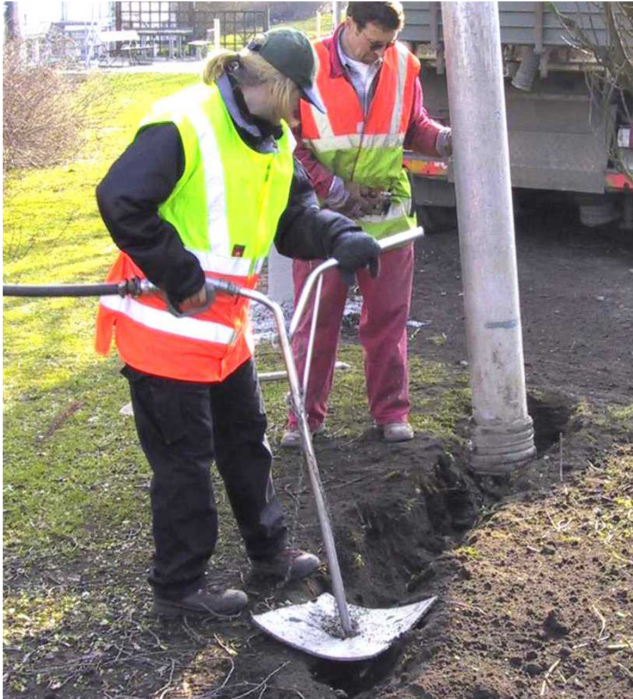
Arbeiten mit der Vakuumtechnik. Mit der Druckluftlanze wird die Erde locker geschossen, damit sie dann aufgesaugt werden kann. Die Druckluftlanze wird auch zur Auflockerung von Terrasse und vorhandenen versiegelten Flächen benutzt.
