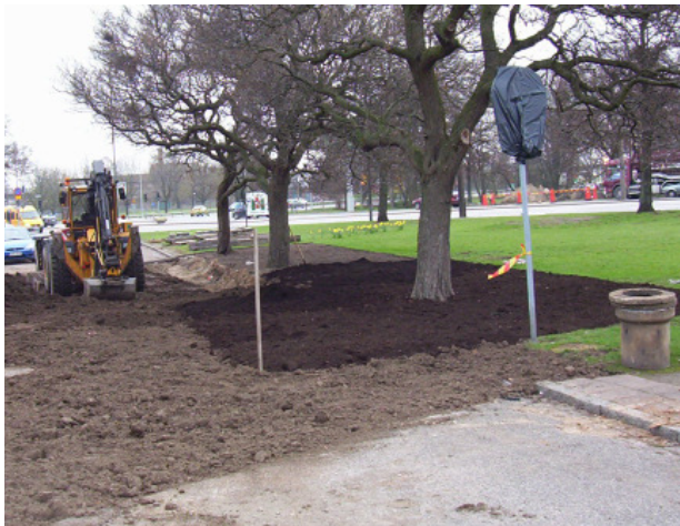
Auslegen von neuer Pflanzerde Typ A in der Schachtgrube der alten Strasse. Eine neue, extra nährstoffreiche Schicht von humusreicher Pflanzerde wird auf das aufgelockerte und ausgeschachtete Wurzelsystem ausgelegt. Danach entsteht eine neue zusammenhaltende Parkfläche mit pflanzgrubenrenovierten Flächen
