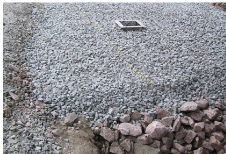
Eine luftige Tragschicht wurde rings um einen Luftbrunnen ausgelegt. Danach kommt Geotextil und zum Schluss Splittermaterial und Belag. (Foto: Björn Embrém)
