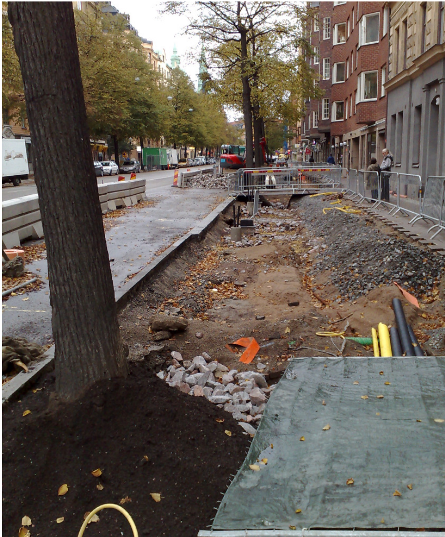
Ausschachtungen in Birger Jarlgatan in Stockholm. Die Pflanzgrubenrenovierung wird in Zusammenhang mit dem Bau von Fahrradwegen durchgeführt. Das vorhandene Wurzelsystem wird mit ausgelegter Pflanzeerde gegen Austrocknung geschützt. (Foto: Örjan Ståhl)
