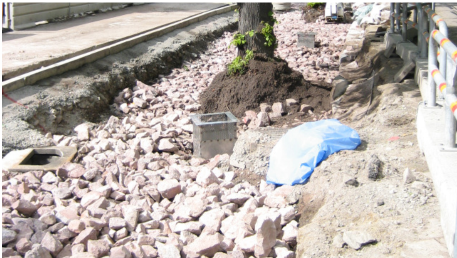
Vorhandene Strassenbäume nach einer Schachtarbeit. Man hat angefangen, Skelettscherben auszulegen und Luft- und Abwasserbrunnen wurden direkt auf die Scherben gesetzt. (Foto: Björn Embrém)
