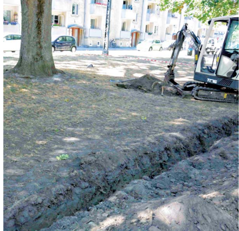
Figur 7. Er der god plads, graves en eller flere grøfter i passende afstand fra træet for at få kendskab til røddernes lejrning og størrelsesfordeling.
