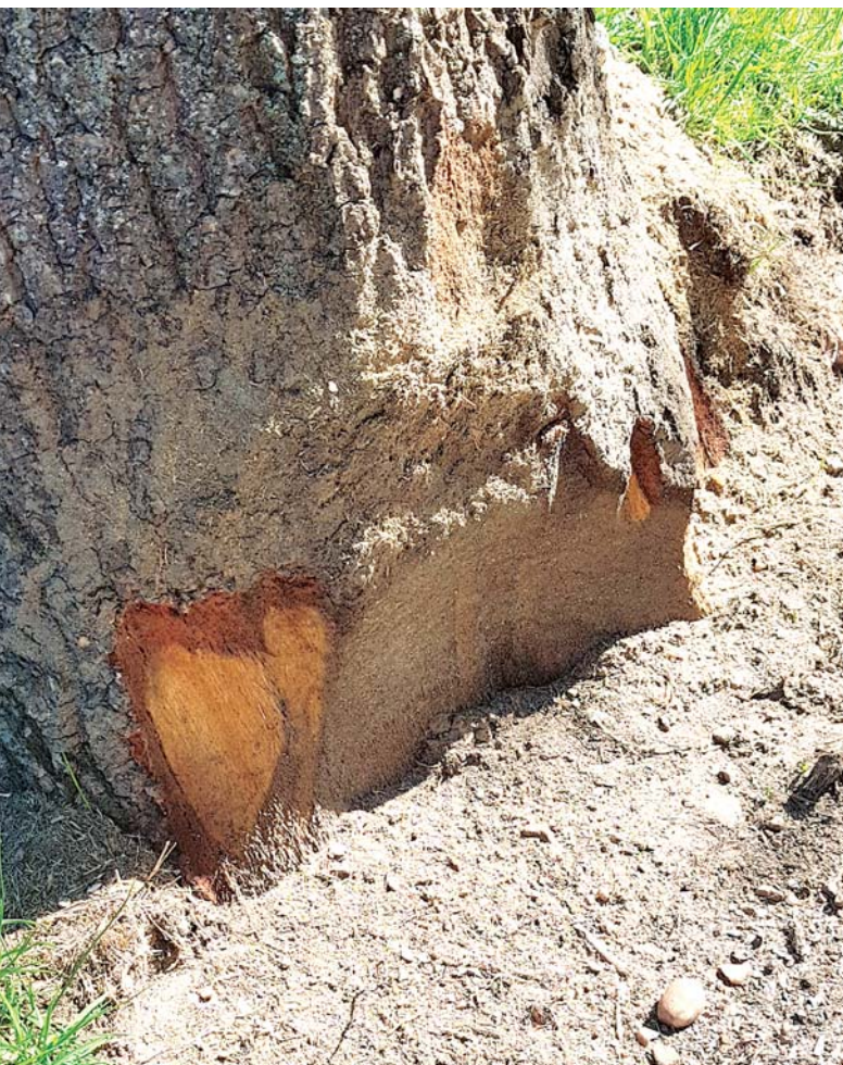
Figur 1. Bortfræsedes støtterødder i forbindelse med renovering af fortov.
