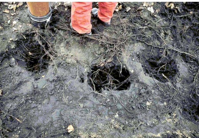
Figur 9. Dybe udluftningsrør til luftskifte i dybe jordlag. Her gennemført i plantegruben tæt rundt om træet. Man ser sugerøret øverst i billedet.
