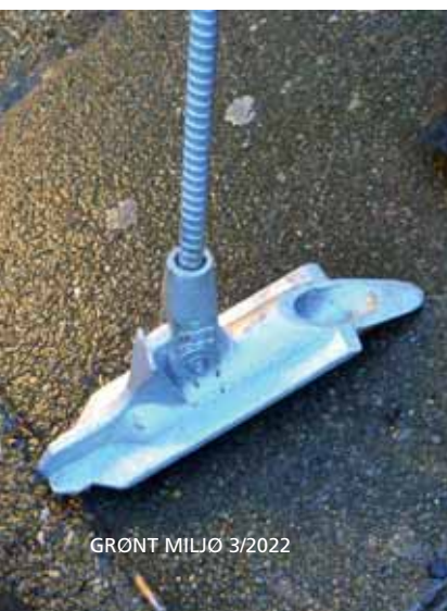
Figur 4: En harpunanker foldes ud efter installation ved at trække i ankerstangen. Herved sætter ankeret sig 'på tværs' i jorden.
