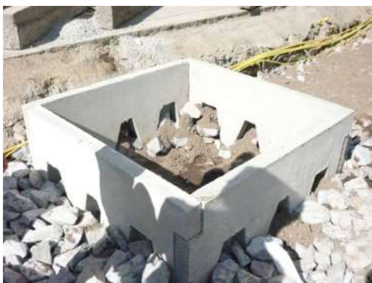
Figur 2: Eksempel på macadamopbygning omkring plantehullet. Plantehullet er omgivet af betonelementer for at forhindre en komprimering af jorden i plantehullet (foto: Oliver Bühler).
