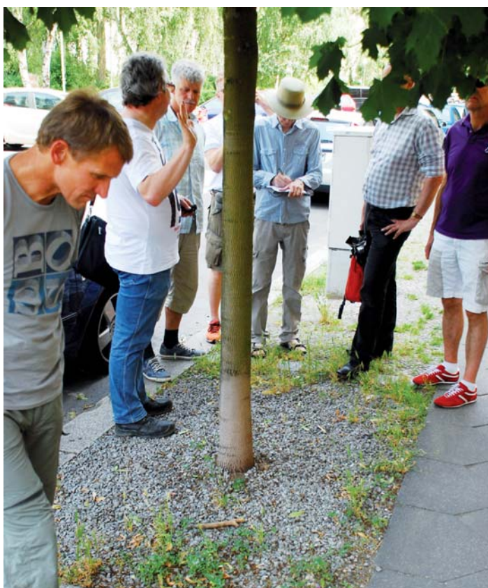
Overfladen fyldes i en dybde af cirka 10 cm med knust granit (8-16). Det modvirker komprimering, forsegling af jorden og akkumulerer betydelige mængder regnvand fra fortovet. Foto: Christian Nørgård Nielsen.
